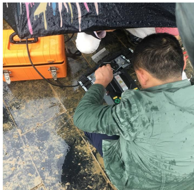
现场熔接光纤图 4
